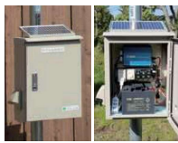
◇BOX外観 ◇BOX内部
